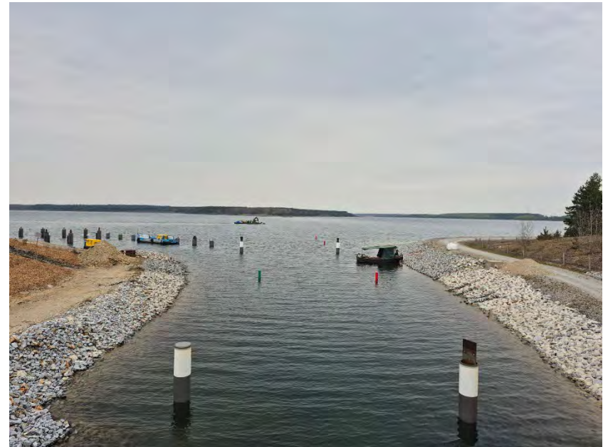
Restarbeiten ÜL 10 (Fahrbahn, lokale Deckwerkserneuerung)
