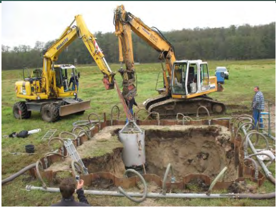
Bau der Grundwasser-Lysimeter Anlage im Spreewald
