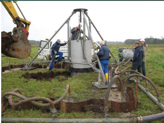
Bau der Grundwasser-Lysimeter Anlage im Spreewald
