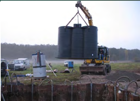
Bau der Grundwasser-Lysimeter Anlage im Spreewald
