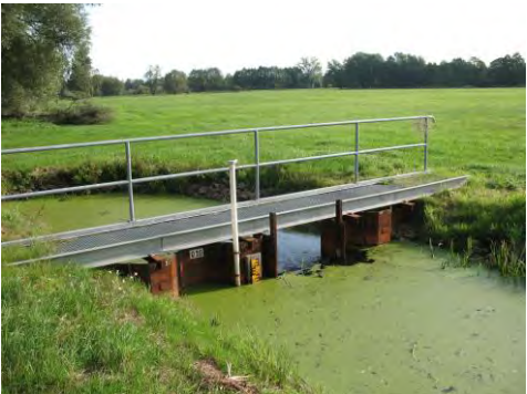
Ent- und Bewässerungsanlagen in Feuchtgebieten
